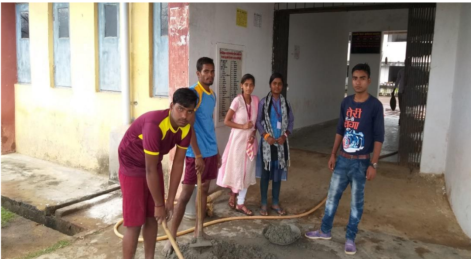
सिमेन्ट की खंभो का निर्माण
